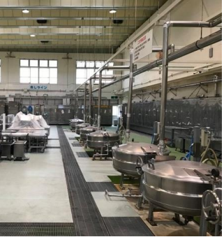
老朽化が著しい現センター 空調設備もなく、夏場の調理は大変な労務です。
